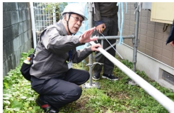
現場の安全チェックを行う様子
